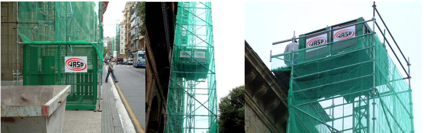
Montacargas para obra / Material Hoist Rehabilitación / Rehabilitation
