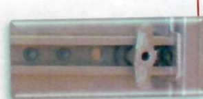
diwidag y tuerca integradas en el panel.
